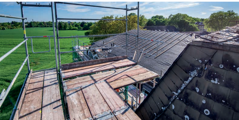
In die Dachsanierung der Seniorenwohnanlage in der Bielefelder Straße 138 investierte der Bauverein im Jahre 2025 für den zweiten Bauabschnitt rund 451.000 Euro.
