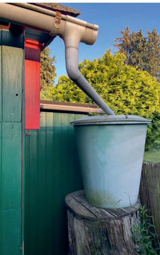
Ein probates und fast selbstverständliches Mittel gegen den Klimawandel: Die eigene Regentonne mit Anschluss an die Dachentwässerung.
