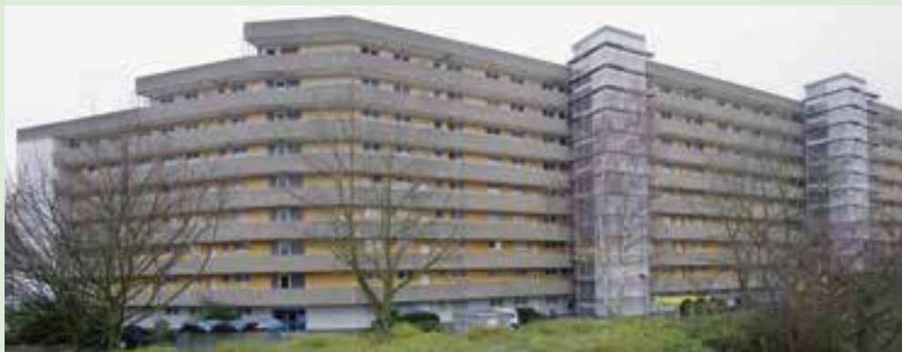
Neue Fassade für die Engelsruhe
