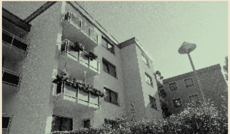
Wohnen am Bahndamm
