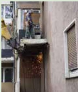
Alte Balkone werden demontiert
