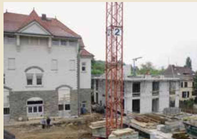
Die alte Lehrlingswerkstatt wird saniert, daneben neu gebaut
