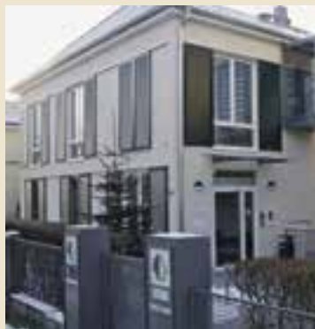
In der Sindlinger Bahnstraße ist das neue Zuhause des Bauvereins
