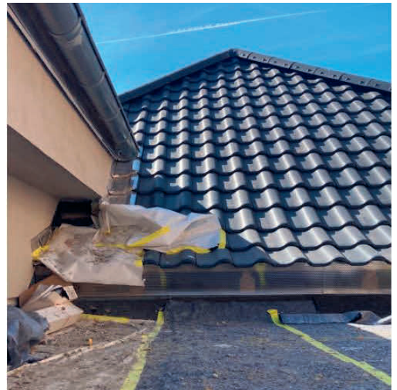
Dachsanierung Senioren- wohnanlage Bielefelder Str. 138 – 2. BA Kosten in 2025: ca. 451 TEUR
